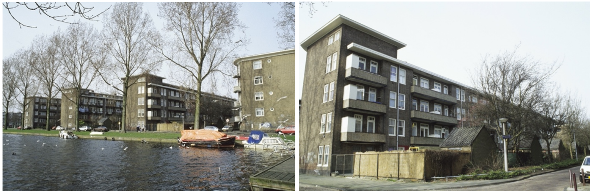
Amsterdam Row building in Bos en Lommer 1922, Stadsarchief Amsterdam / Alfons Holslag
