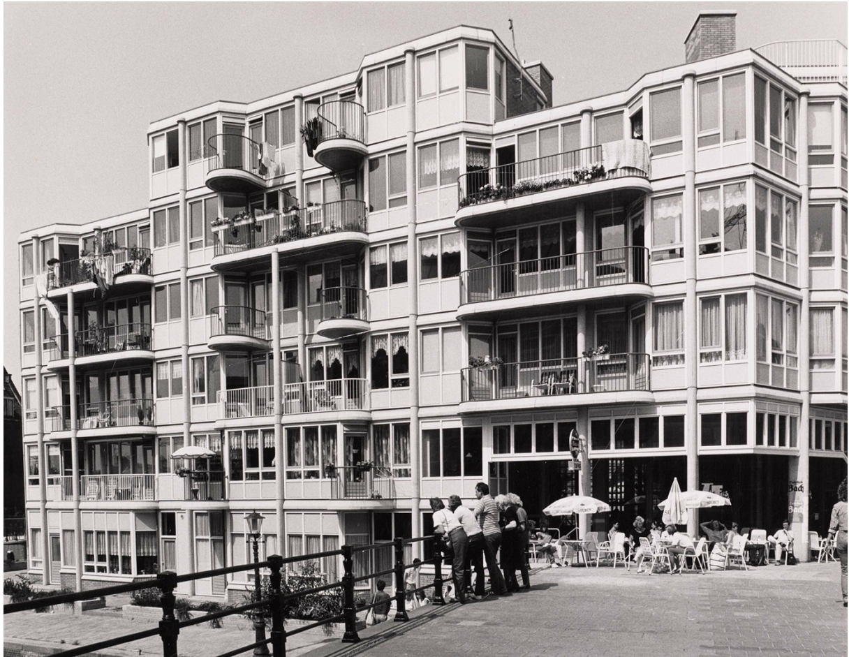
Amsterdam Sint Antoniesbreestraat 'Pentagon' 1984 (arch. Van Eijck & Bosch), Stadsarchief Amsterdam / Dienst Volkshuisvesting
