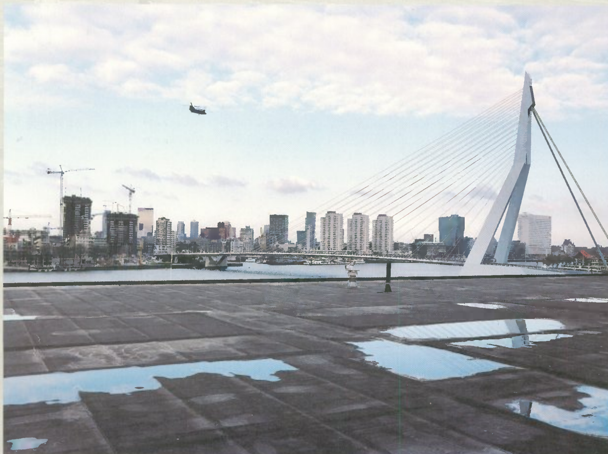
Het dak van werkplaatsengebouw Las Palmas.
